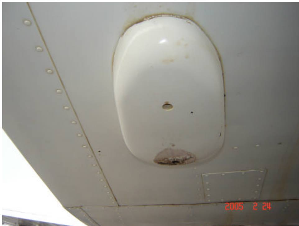
DAÑO EN LAS ANTENAS DEL ADF
